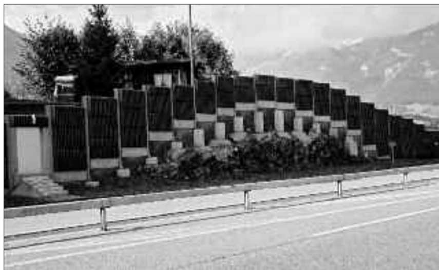
Dem Gelände angepasste Lärmschutzwand bei Sarnen.
