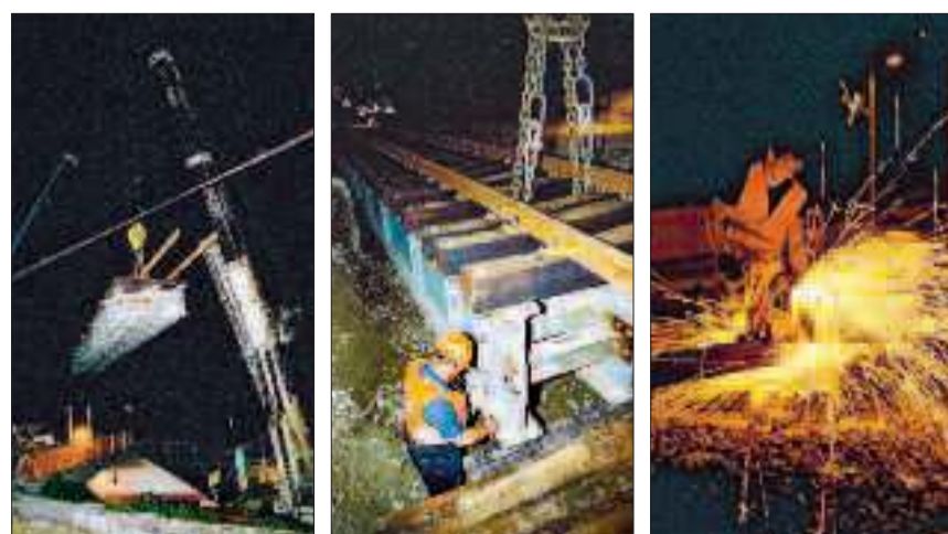
Spektakulärer Einbau der 75 t schweren SBB-Hilfsbrücke beim Portal Z'Matt.
