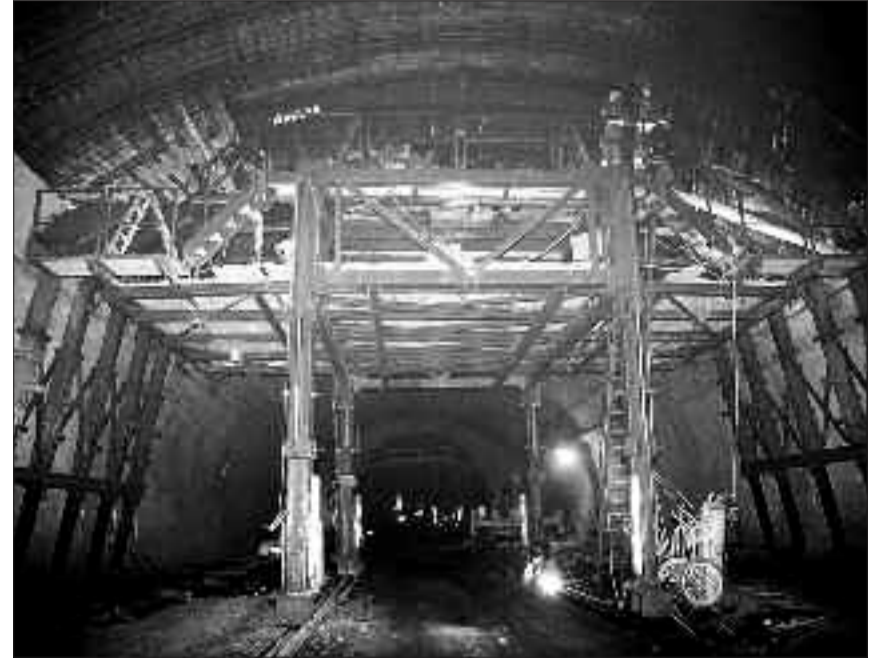
Betonschalung für Kalotte in der Ausstellnische.
