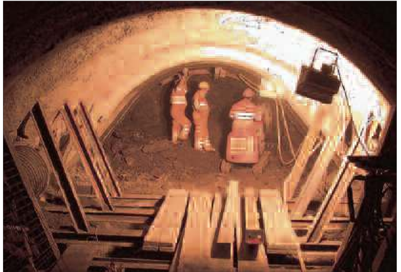
Firststollen über Erkundungsstollen mit Stahleinbau gesichert.
