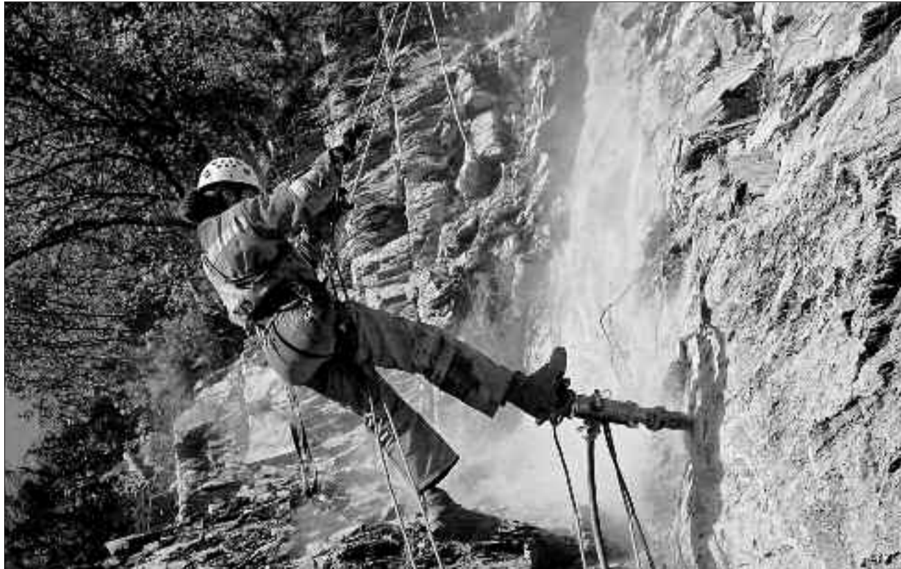
Akrobatische Steinschlagschutz-Arbeiten oberhalb der Brünigpassstrasse.
