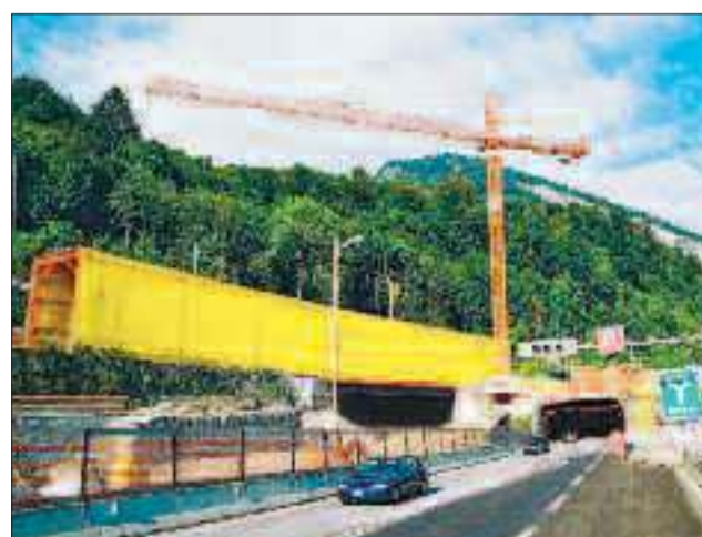
Bahnschutzunnel über neuem Tunnelportal.
