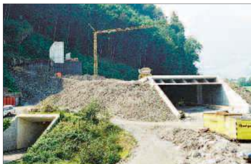
Nordportal Tunnel Giswil mit Abluftkamin.
