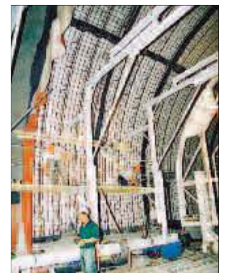
Montage der Abdichtung auf Stützkonstruktion.
