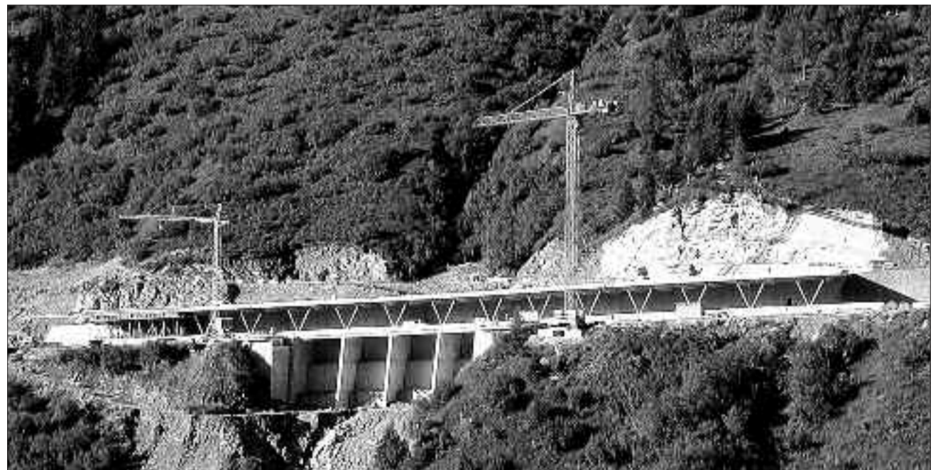
Lawinengalerie Ri di Rialp, Lukmanierpassstrasse.
