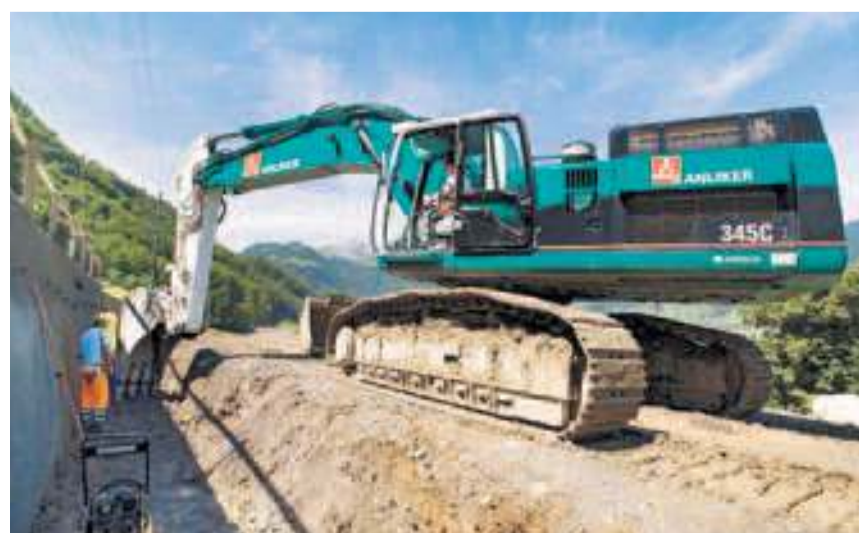
Aushub für Tagbautunnel Zollhaus.
