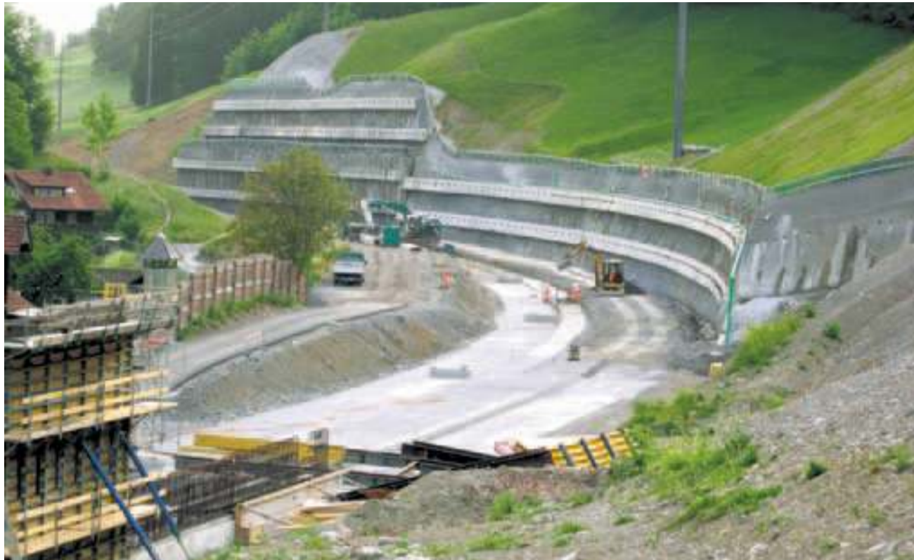
Tunnelbaugrube mit rückverankerter Bohrpfahlwand und Riegelwand.
