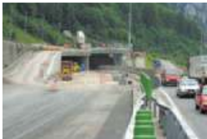
Portal z'Matt im Bau.
