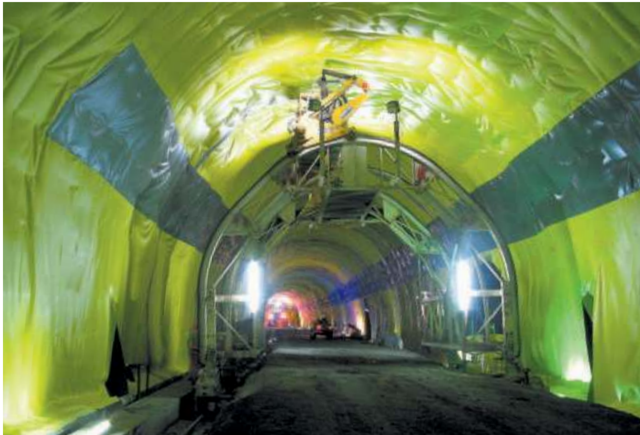
Gewölbeabdichtung mit Sika Sarnafil Folie im Tunnel Lungern.
