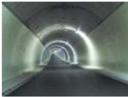
Verbindungstunnel im Rohbau.
