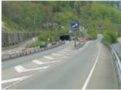
Portal z'Matt vor Baubeginn.
