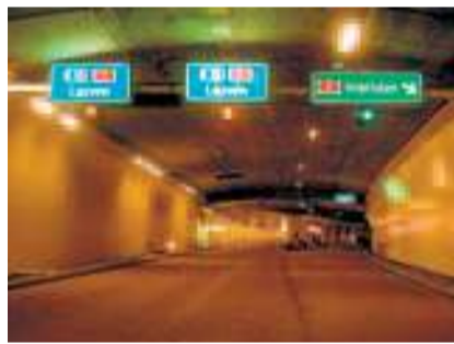
Abzweiger Richtung Obwalden.
