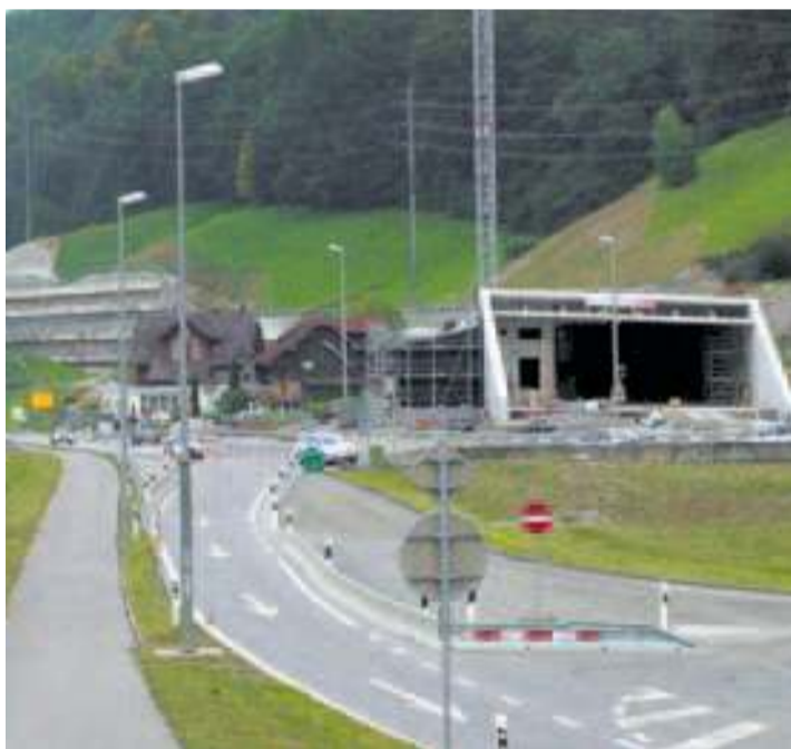
Südportal mit angebauter Elektrozentrale.
