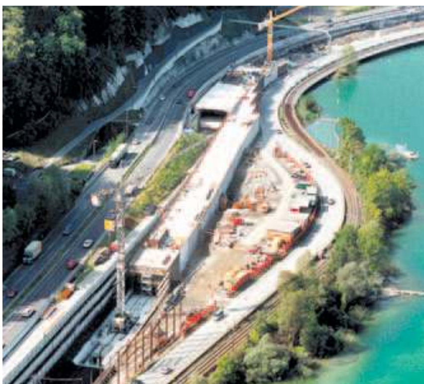
Bahntunnel Haltiwald Horw/Hergiswil.
