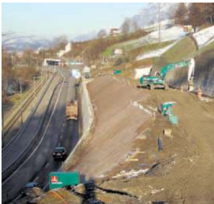
Trassearbeiten gegen Südportal Tunnel Sachseln.
