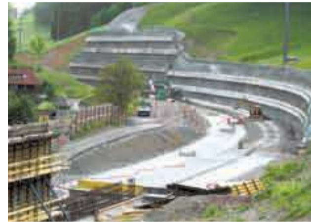
Bohrpfahlwand, Mai 2008, Höhe bis 20 m
