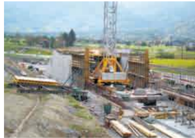
Start der Betonarbeiten Tunnel, Mai 2008
