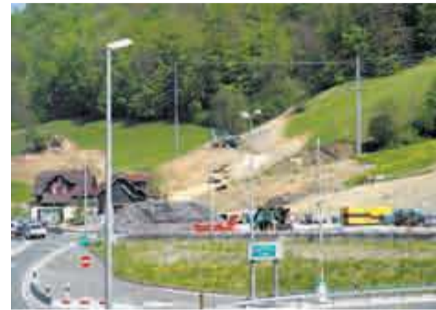
Beginn der Erdarbeiten, April 2007
