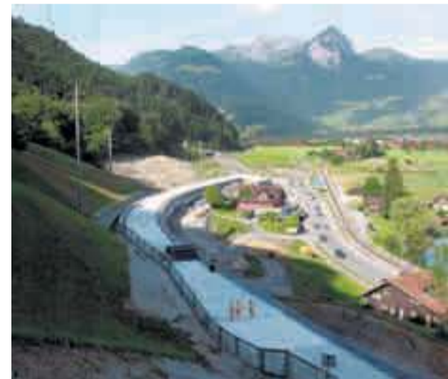
Stand Tunnelbau, Juni 2009
