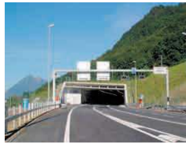
Südportal mit Stanserhorn
