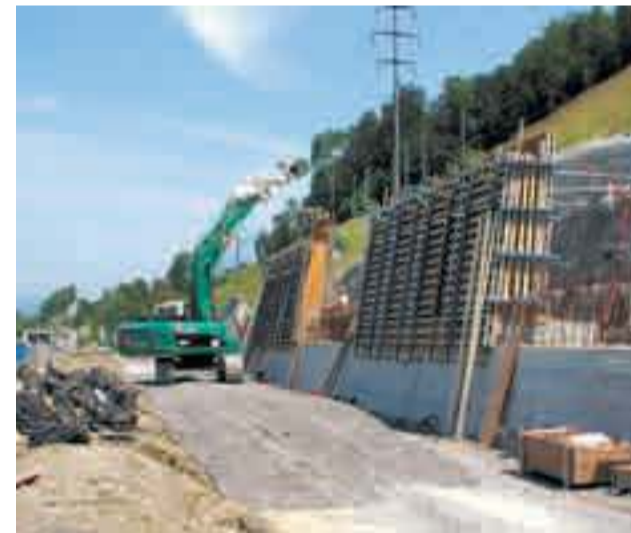
Bau der Stützmauer, Juni 2009
