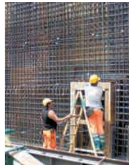
Armierung der Tunnelwände
