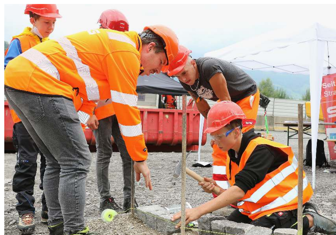
Obwaldner Orientierungsschüler üben das Baggern und Pflastern vor dem Kaiserstuhl-Tunnel.
